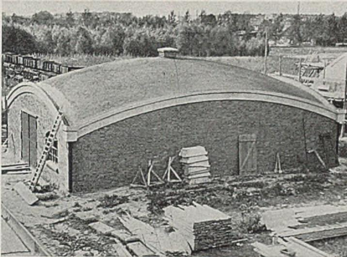
Abb. 12. Schalenkuppel über einem stützenfrei überdeckten Grundriß von 10×15 m, ausgeführt von der Dyckerhoff & Widmann A.-G., Spandau. Die Kuppel ist nach einer Rückungsfläche geformt, deren Leitkurven zwei Kreise mit verschiedenem Radius sind. Die Schalendstärke beträgt 6 cm.
