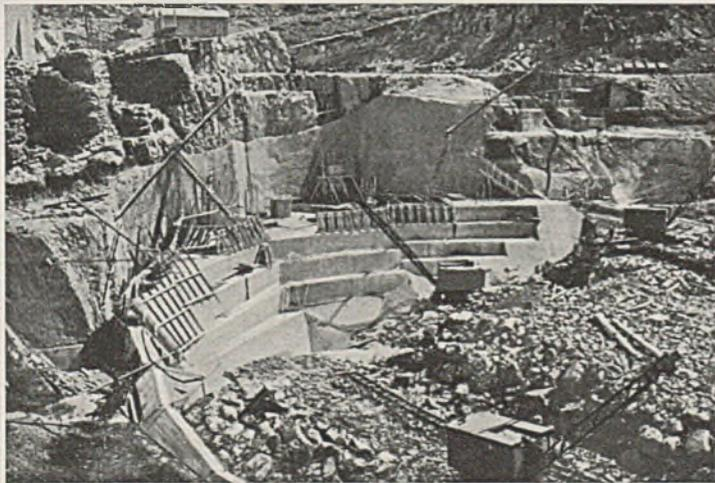
Abb. 7. Fom-el-Gueiss-Staudamm. Herstellung der Anschlußmauer am rechten Hang.
