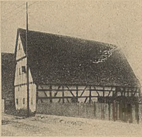
Abb. 8. Übertritt eines Blitzes vom Dach in ein Niederspannungsnetz
