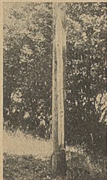
Abb. 7. Blitzkanal an einem Holzmast mit Erdungsdraht.
