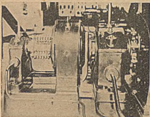
Abb. 31 Abtropfbleche und Blechschürze (Mitte) an der Erregermaschine eines Dampfturbo-Aggregates
