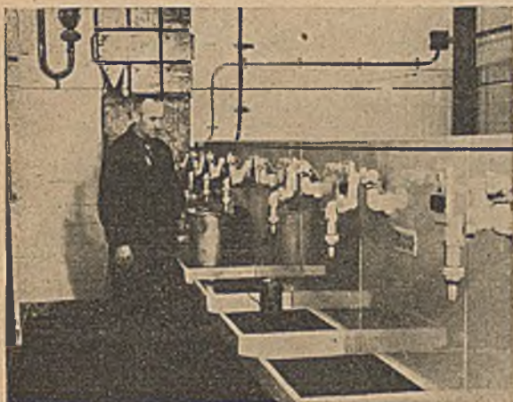
Abb. 7 Oelausgabestelle im Groß- betrieb — Vorderansicht
