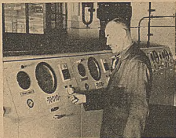
Abb. 8 Oelausgabestelle — Rück- ansicht (Schalttafel mit Meßuhr)
