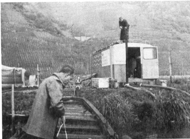
Bild 22: Das Großgerät von Berkefeld mit 50000 l/h Leistung beim Einsatz zur Versorgung der Gemeinden Alf und St. Aldegund mit aufbereitetem Wasser aus der Mosel. Werksfoto Berkefeld
