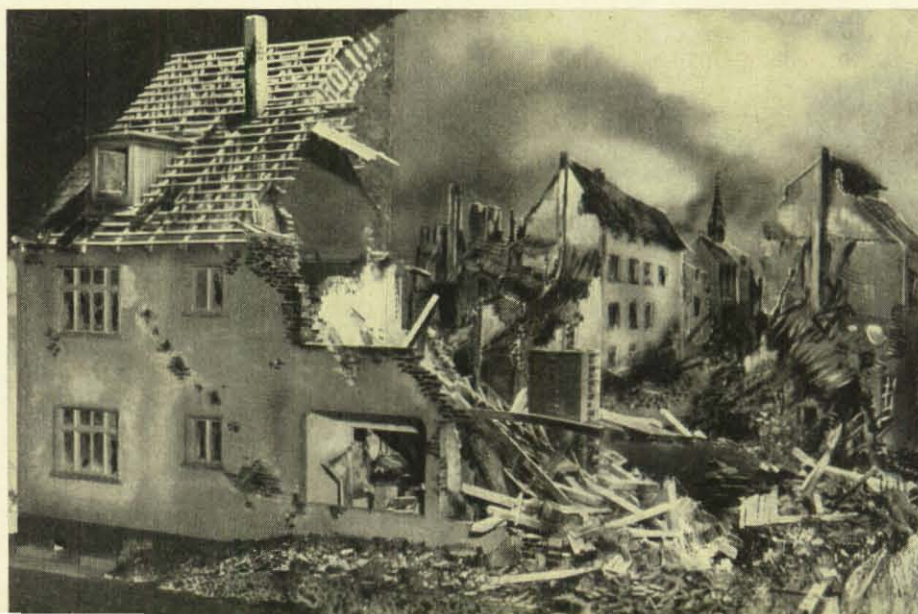
Dies ist ein Modell eines durch Bombentreffer zerstörten Vier-Familien-Hauses für Übungen in der Einsatztaktik am Einzelobjekt. Die sinnvolle Konstruktion des ausgezeichneten Modells gestattet seine völlige Zerlegung entsprechend den verschiedenen Phasen der Beräumung.
