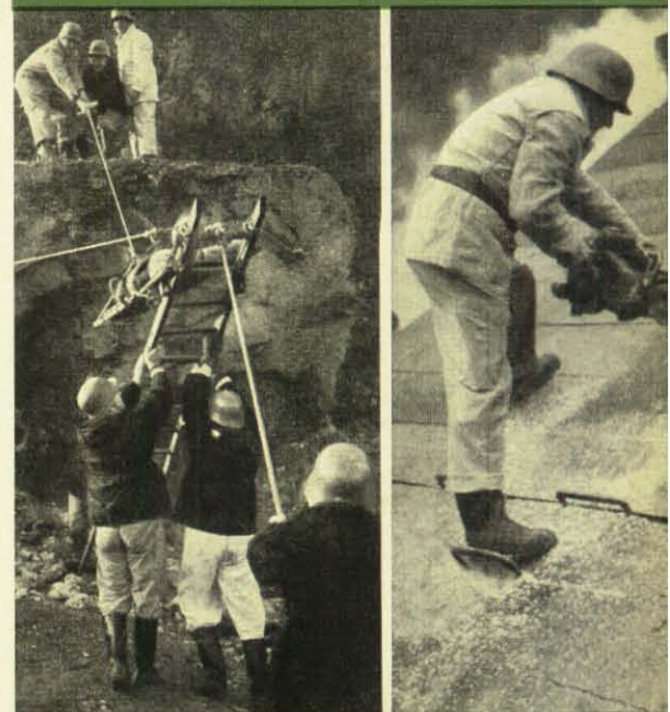
Vielfältig sind die Bergungsmöglichkeiten, die jeder THW-Helfer beherrscht (Bild links). Einstiegsöffnungen in Holzdächer oder Holzwände (rechtes Bild) werden in kurzer Zeit mit der Motorsäge geschnitten.
