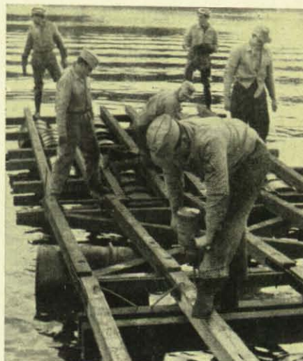
Tonnensteg im Bau
