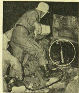
Abb.: Räumen von Trümmern mit LUKAS
