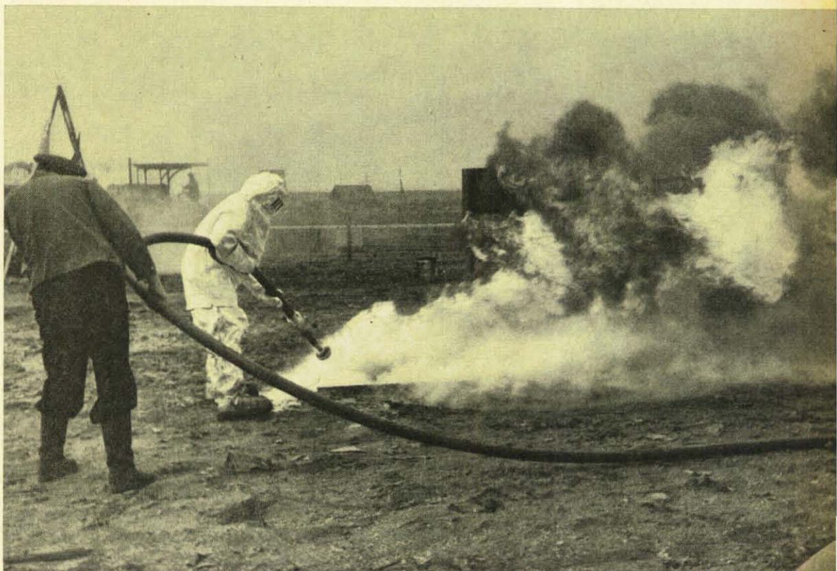
Aluminiumbeschichtete Flammenschutzanzüge ermöglichen den Kräften der Feuerwehr ein nahes Herankommen an Großbrände, wodurch schon oftmals die sonst unmögliche Menschenrettung möglich wurde.
