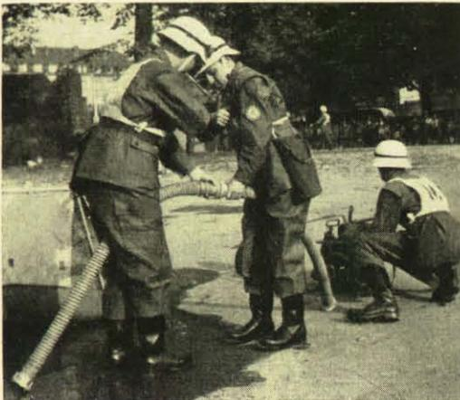
Beim Öffnen und Schließen der Saugschlauchkupplungen bedienen die Helfer die Kupplungsschlüssel mit der rechten Hand. Da beim Öffnen der Schlüssel auf der Gegenseite angesetzt wird, erfolgt auch diese Bewegung wie die Schließbewegung im Uhrzeigersinn.
