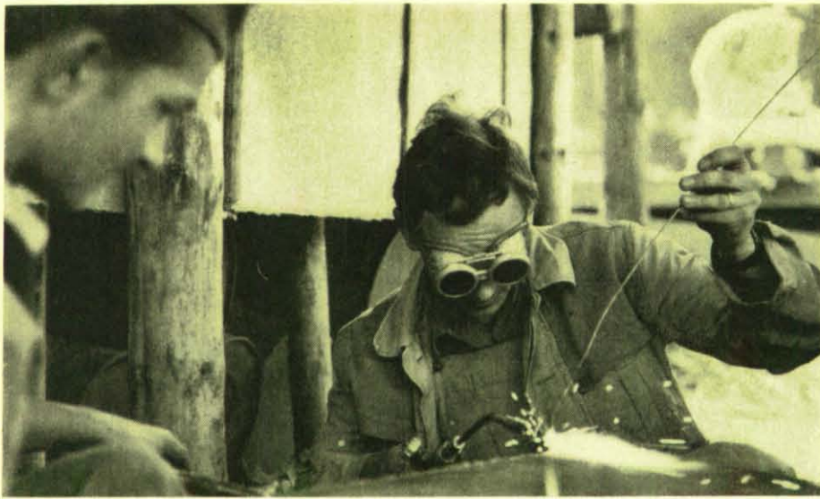
Bild oben: Die Herstellung der Öfen verlangt fachliches Können. Hier werden die Winkelstücke für den Bau der Warmhalte-Röhre im Ofen angeschweißt. Zeichnung unten: Verschiedene Arten von Windlichtern zum Aufstellen oder Aufhängen, die mit einigem Geschick selbst gebastelt werden können. Bild ganz unten: Für feuersichere Gebäude und Räume lassen sich Kerzenhalter aus den Wurzelenden der Stämme dünner Bäume anfertigen.
