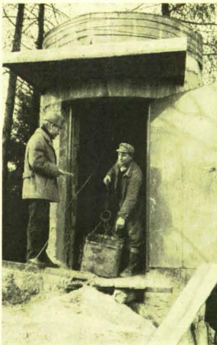
Schutzanlage. Durch den Ausstiegsschacht hat Ludwig Martin in mühsamer Arbeit mit Hilfe eines geliehenen alten DKW-Motorradmotors als Antriebskraft für eine Seilwinde den Aushub zutage gefördert. Es waren gewaltige Massen. Heute arbeitet die Winde mit einem Elektromotor.
