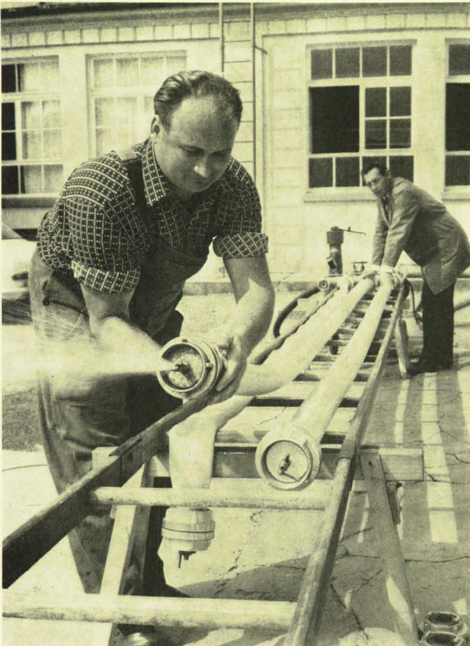
**Links: Das Einbinden von Druckschläuchen unter Verwendung einer Einbindemaschine mit Elektromotor. Darunter: Bevor die Schläuche das Werk verlassen, werden sie mit Hilfe der Elektro-Schlauchprüfpumpe nochmals überprüft.**
