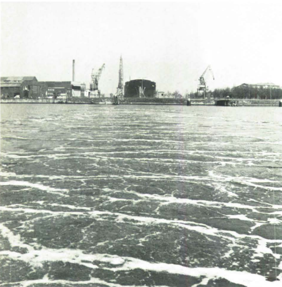
Die Ölsperre in Betrieb. Äußeres Kennzeichen ist die 175 m lange Blasenbahn, an der das Öl durch die gegenläufige Wasserströmung zurückgehalten wird.
