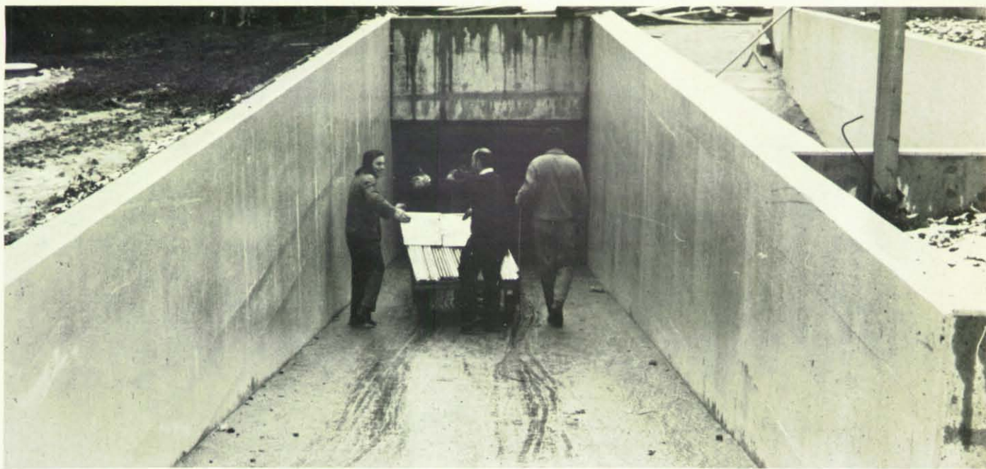
Eine der Einfahrten in die Tiefgarage in Amberg.
