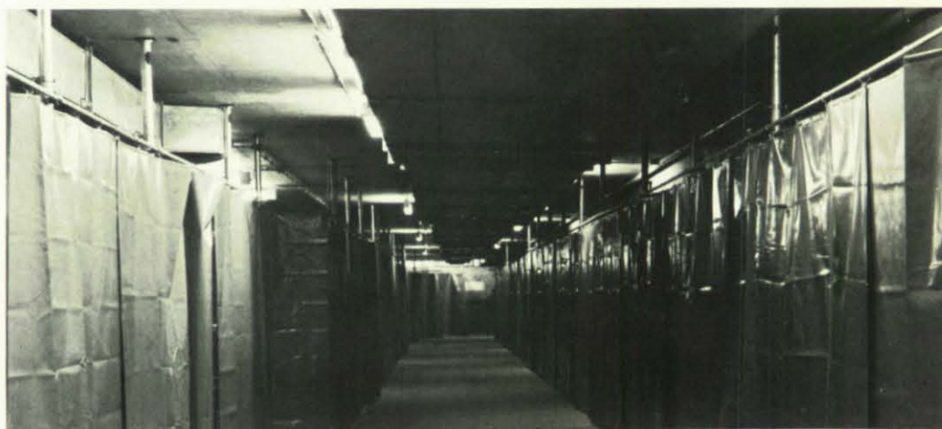
Parkdeck als Schutzraum eingerichtet: ein Flur zwischen eingehängten Trennwänden.
