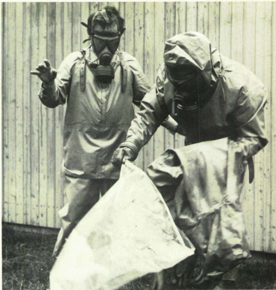
Sammeln kontaminierter Schutzbekleidung in Kunststoffsäcken.
