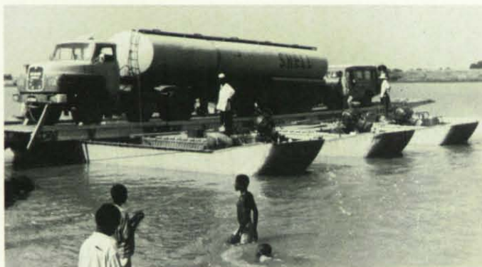
Die vom Technischen Hilfswerk erbaute Fähre versieht ihren Dienst auf dem Shari-Fluß.
