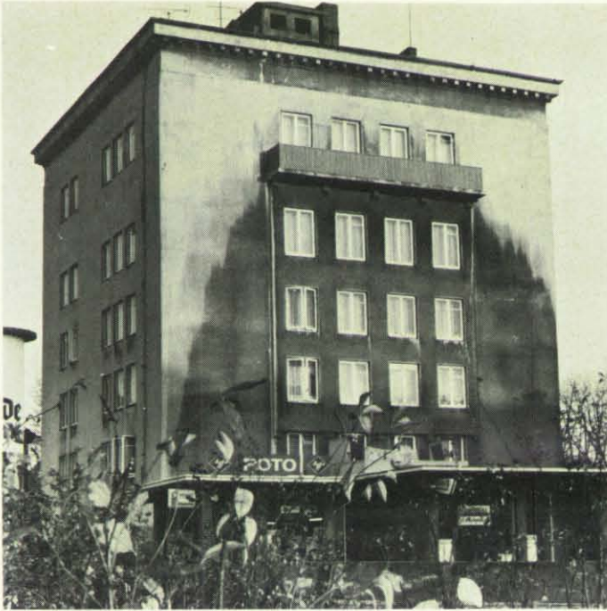
Auch Wohnhäuser lassen manchmal ihr früheres Gesicht erkennen.
