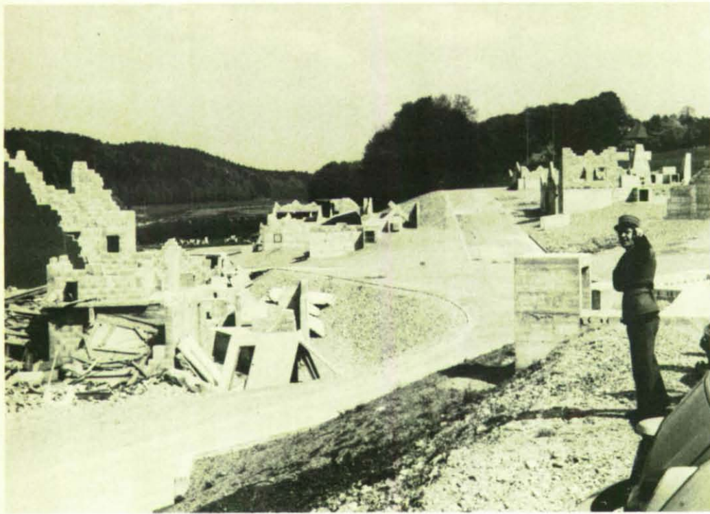
Bergung und Rettung können an Schadensmodellen im Maßstab 1:1 der Luftschutztruppen-Schule Wangen geübt werden.
