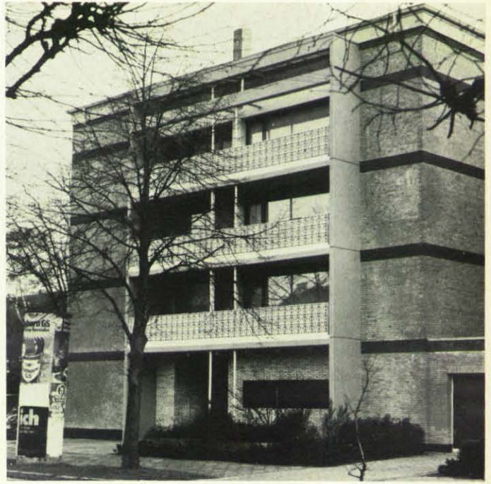
Die architektonisch geschickte Kaschierung eines ehemaligen LS-Bunkers in Wilhelmshaven.
