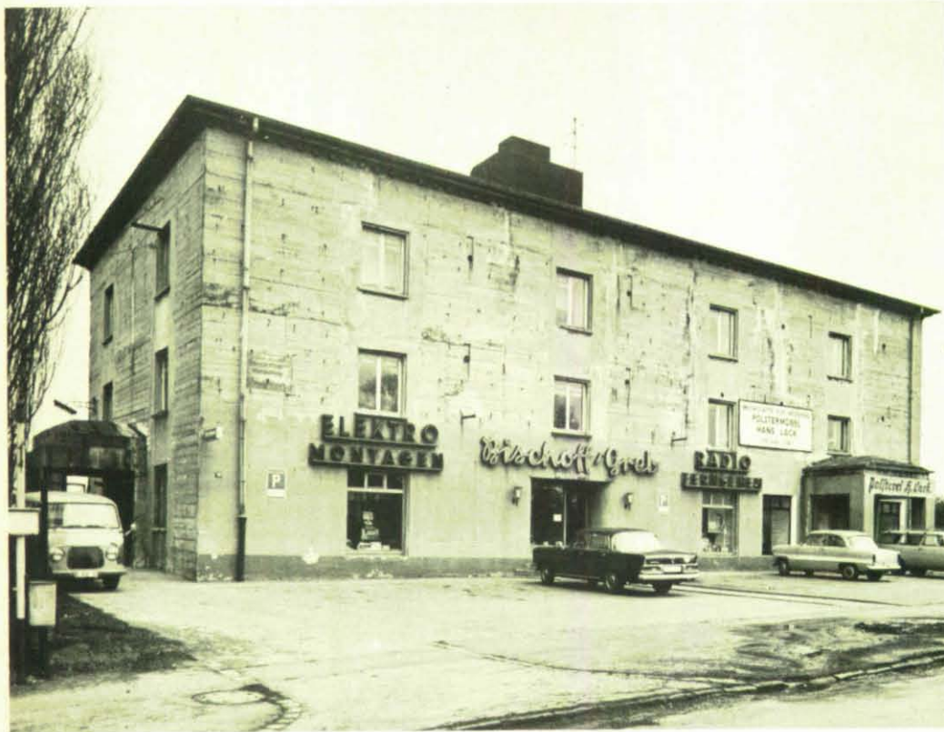
Ein Beispiel für den erfolgten Umbau eines Bunkers. Läden, Werkstätten, Lager sind nicht die einzige Möglichkeit der Nutzung.
