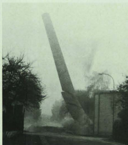
Nach der Zündung kippt der Kamin in die vorbestimmte Richtung.
