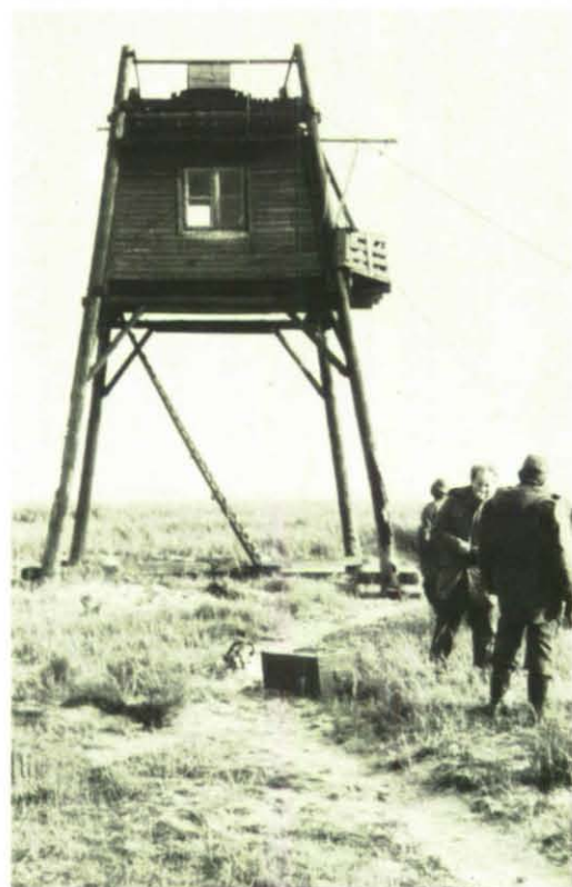
Der alte, ausgediente Knechtsandturm vor dem Abriß.
