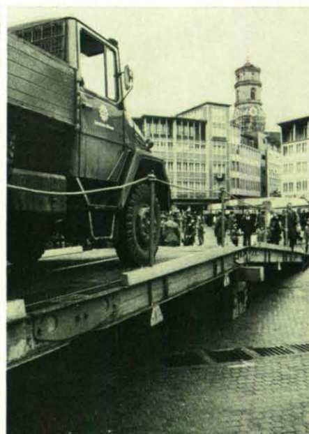
THW-Helfer aus Pforzheim bauten diese 17 m lange Grabenbrücke.
