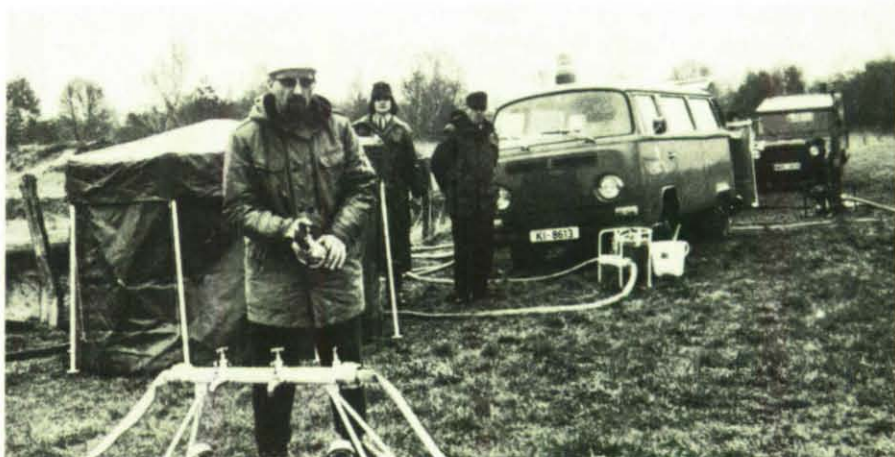
THW-Anlage zur Wasserabgabe bereit.
