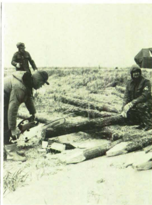
Viermal zehn Pfähle, je 3 m lang, dienen zur Verankerung des Turmes.
