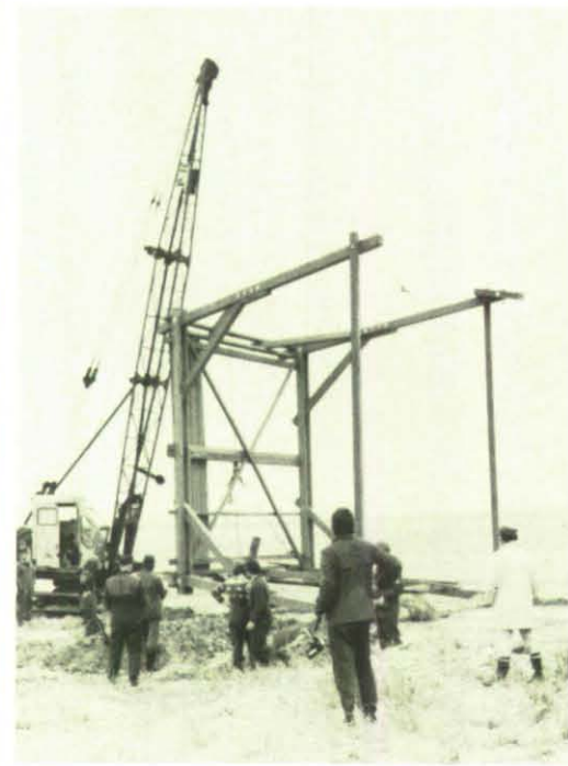
An der Baustelle wird der hölzerne Unterbau aufgerichtet.
