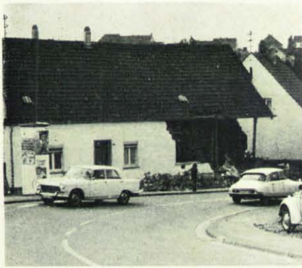
Das stark beschädigte Haus nach den Abstützungsmaßnahmen.
