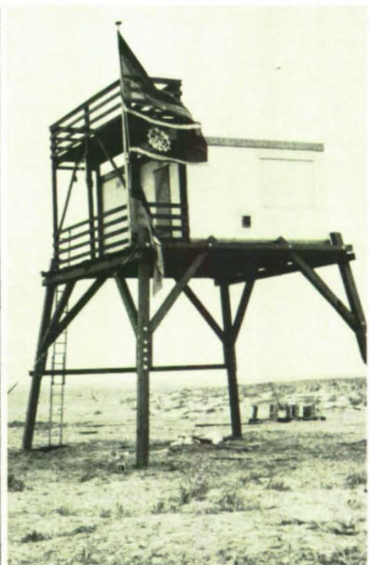
Der neue Beobachtungsturm steht.
