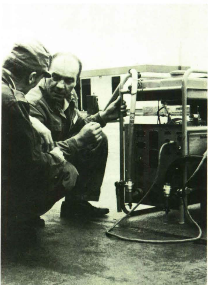
Hier gilt es, einen eingebauten Fehler ausfindig zu machen.
