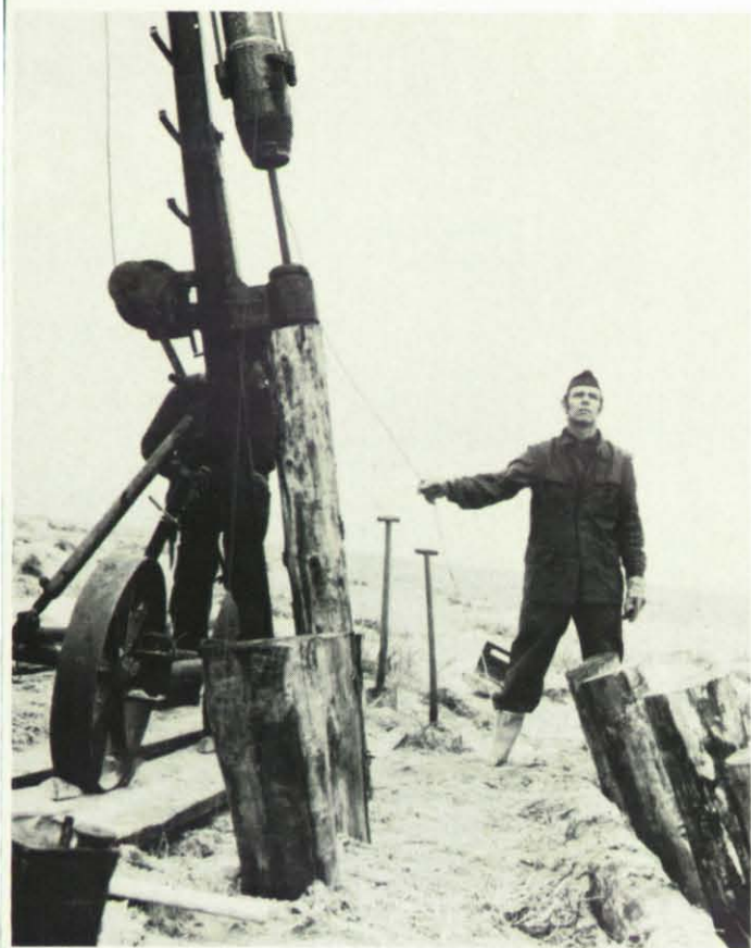
Die 40 Pfähle werden zweieinhalb Meter tief in den Sandboden gerammt.
