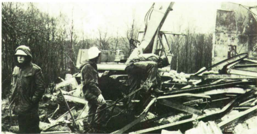
Zerlegen der Stahlkonstruktion mittels Brennschneidgerät.
