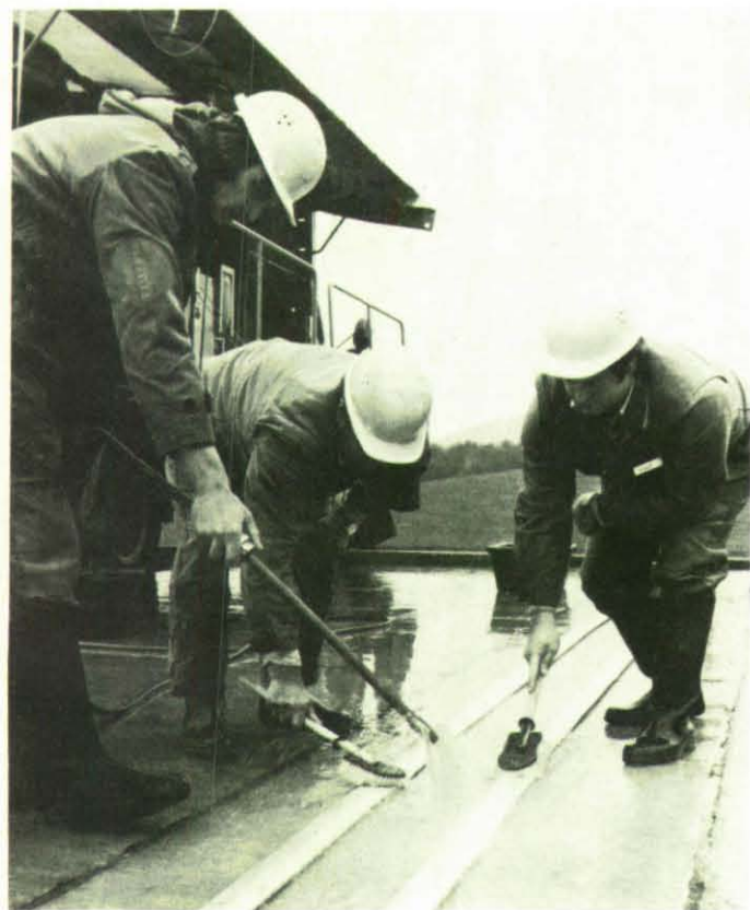
Grober Schmutz muß naß mit weichen Bürsten entfernt werden. Ein Breitstrahlrohr leistet dabei gute Hilfe.
