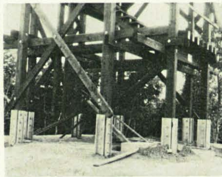
Die acht Konsolen mit je vier U-Eisen für die Verankerung.
