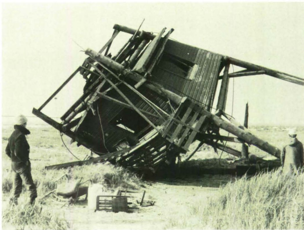
Die Reste des alten Turmes werden verbrannt.
