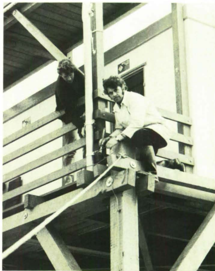
Der Abschluß aller Arbeiten — das Befestigen des Blitzableiters.
