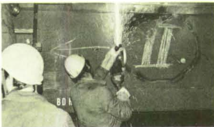
Der Einsatz von Trennschleifern erwies sich als wirksamstes Mittel, um die stabile Waggonaußenhaut aufzubrechen.
