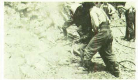
Zu den anstrengendsten Arbeiten gehörte das Bohren der Sprenglöcher.
