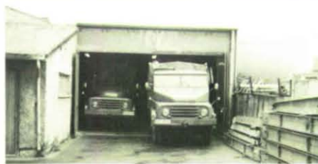
Einfahrt zu einer Garage für fünf Einsatzfahrzeuge (THW-Ortsverband Bad Godesberg).
