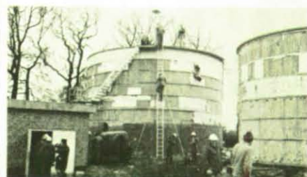
Rund 180 Bohrungen waren erforderlich, um die Sprengung von Faulturn und Klärbecken vorzubereiten.
