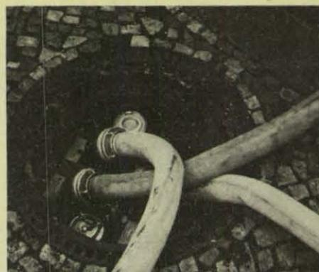
**Bild 17: Schlauchanschlüsse an die Rohrstutzen im Brunnen-schacht eines Berliner Kombi-Wellens.**
