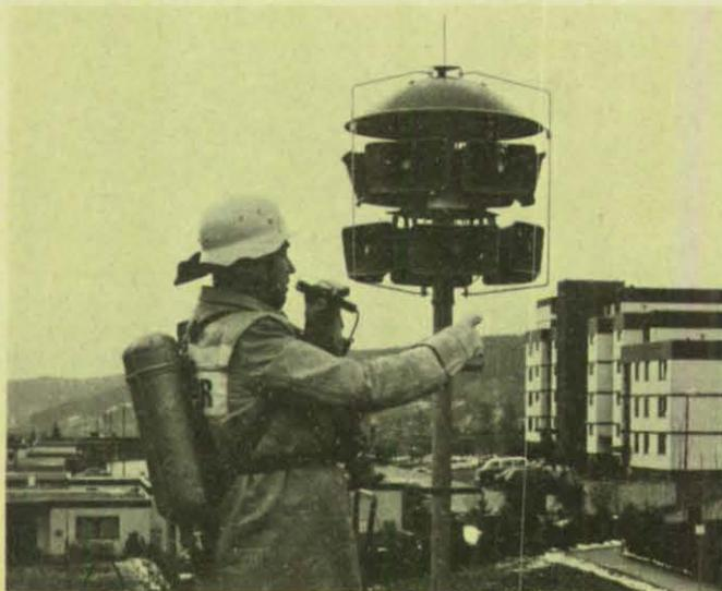
Auch Sprachdurchsagen über Mikrofon, Band, Funk oder Telefon sind über die elektronische Sirene möglich.
