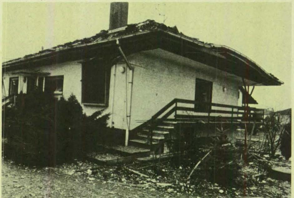
Einige der über 200 beschädigten Häuser; Druck- und Sogwirkung haben ihre deutlichen Spuren hinterlassen.
