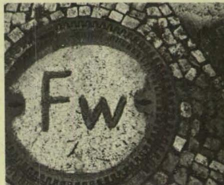
**Bild 18: Schachtabdeckung eines Berliner Kombi-Wellens mit Hinweis auf seine Verwendung zu Löschwasserzwecken.**
