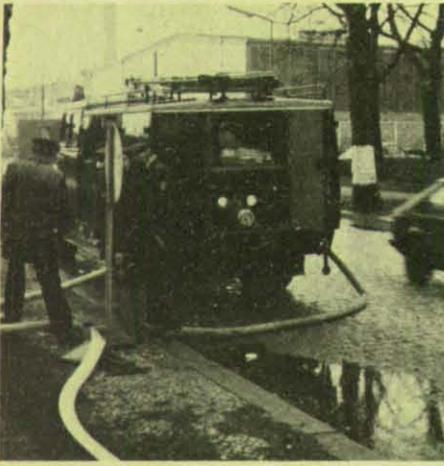
Bild 14: Tanklöschfahrzeug der Berliner Feuerwehr beim Betrieb eines Kombi-Brunnens.
