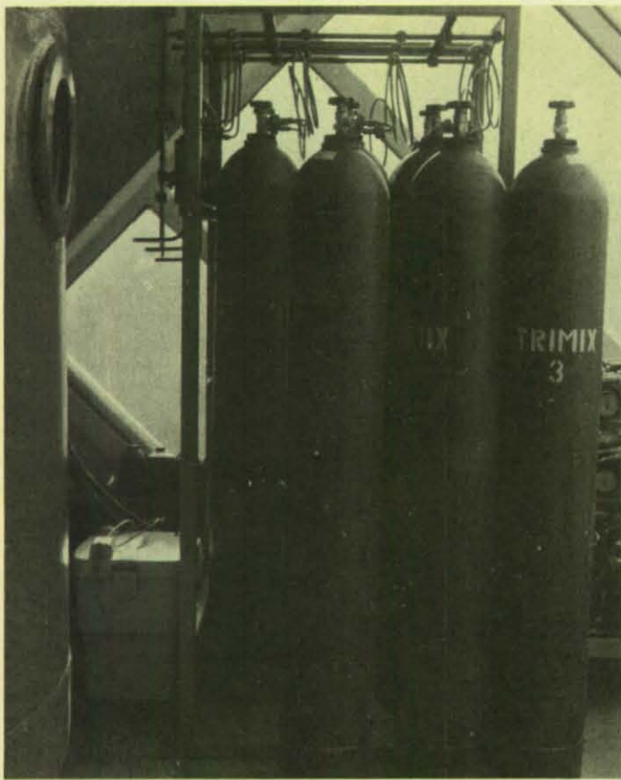
Trimix-Flaschen für die Behandlung unter hohem Druck.
