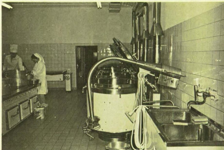
In einem sehr guten Zustand wurde die Großküche übernommen.
