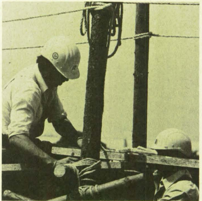
Beim Stegebau waren erheblich mehr Bindeleinen notwendig als in der üblichen Bauweise.
