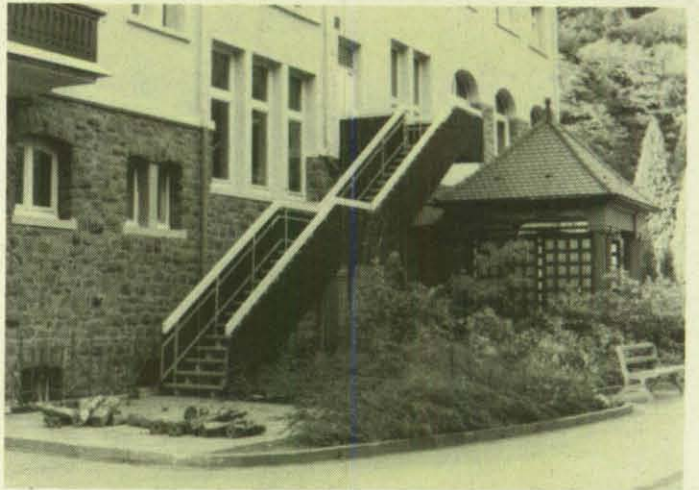
Nachträglich angebaut wurde eine Flucht-treppe an der Vorderfront des Hauses.
