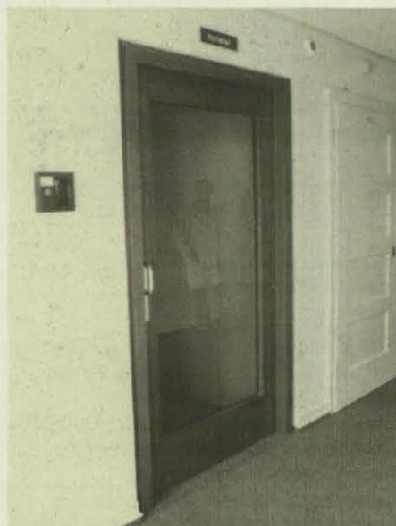
Links: Der Zugang zur Fluchtleiter am Ende des Flurs.
