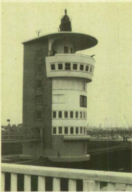
Sitz des Zentralen Meldekopfes und auch der Sonderstelle des Bundes im Radarturm des Wasser- und Schiffsamtes Cuxhaven.
