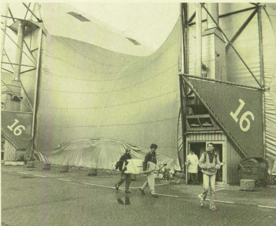
Opfer des Orkans wurde auch die Internationale Bootsausstellung „boot '90“ in Düsseldorf. Eine beschädigte Traglufthalle mußte aus Sicherheitsgründen geschlossen werden.
