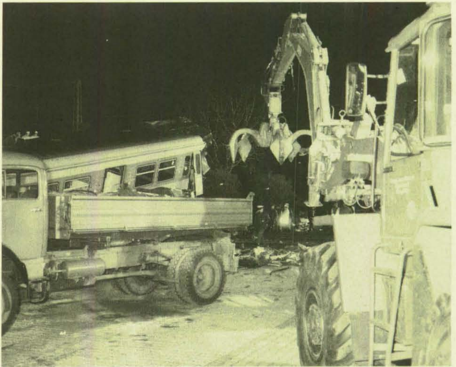
Mit dem Polypgreifer des THW-Radladers werden Fahrzeugtrümmer auf einen Lkw geladen. (Fotos: Hartmann)
