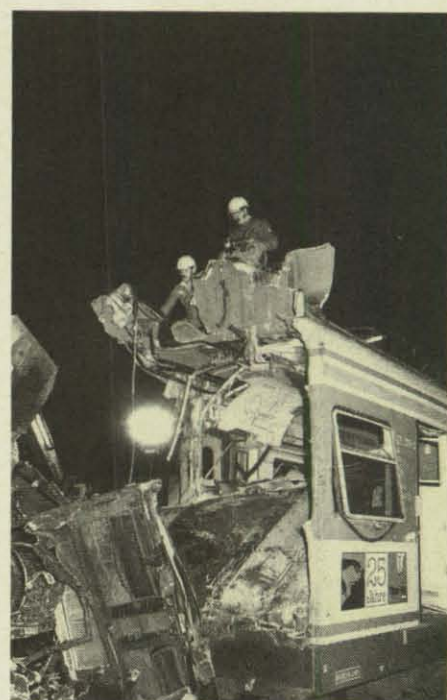
THW-Helfer auf dem Dach eines Waggon. Sie trennen überstehende Metallteile ab.
