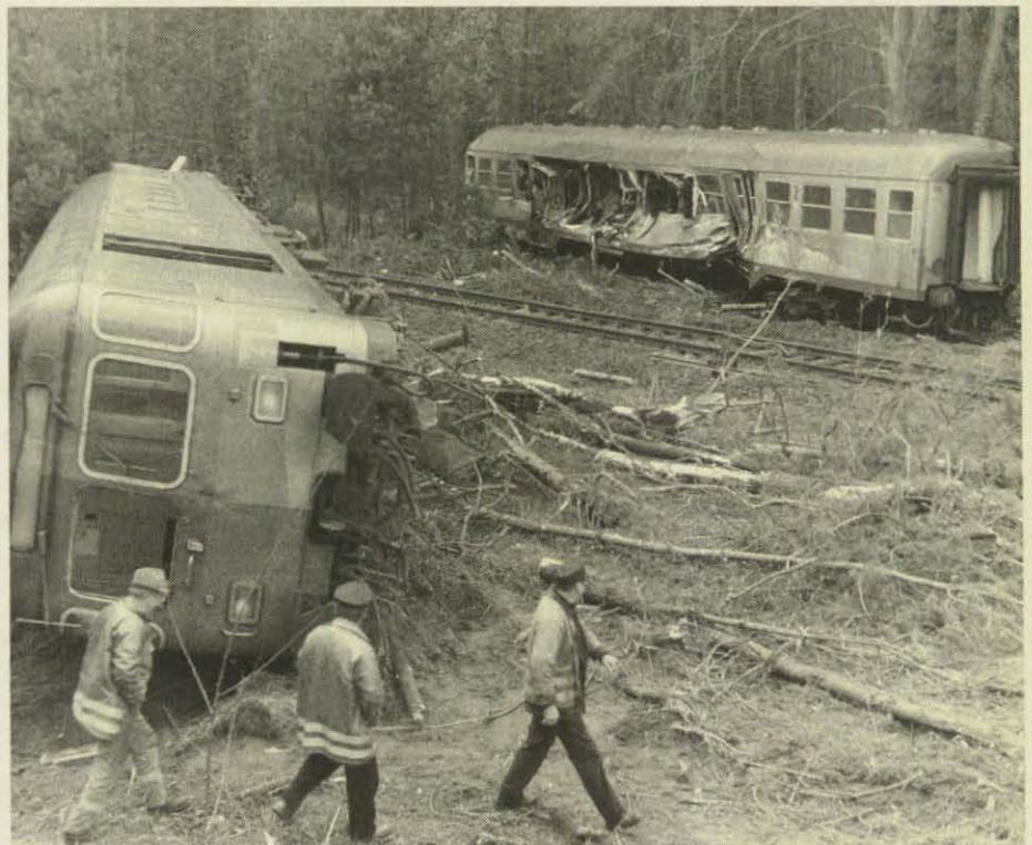
Auch Schienenwege wurden von umgestürzten Bäumen blockiert. Bei Babenhausen in Hessen fuhr ein Nahverkehrszug in ein solches Hindernis, zwei beschädigte Waggons und ein verletzter Fahrgast waren die Folge.
