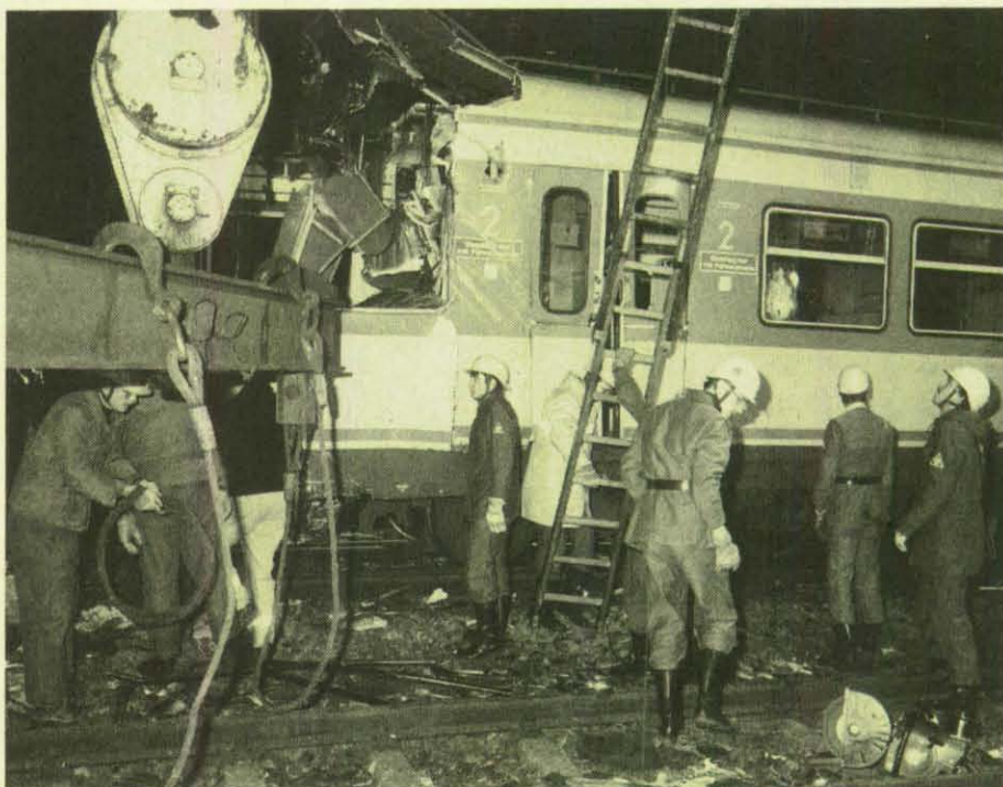
Bundesbahnbedienstete und THW-Helfer heben einen der Waggon wieder auf die Schienen.
