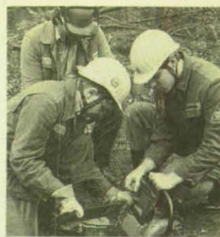
Die Wartung der Kettensäge kann bei den Waldarbeiten praktisch eingeübt werden. (Foto: Grünig)
