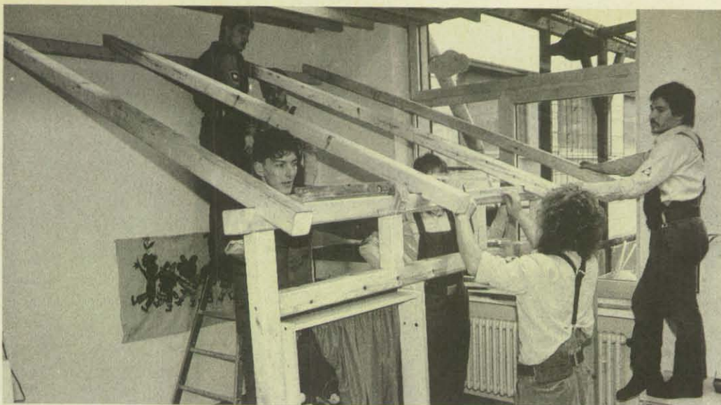
Ohne einen einzigen Nagel erstellt: Das Fachwerkhaus im Kindergarten.
