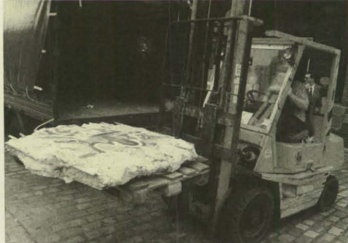
Der Gabelstapler hilft beim Abladen des Mauerstücks.
