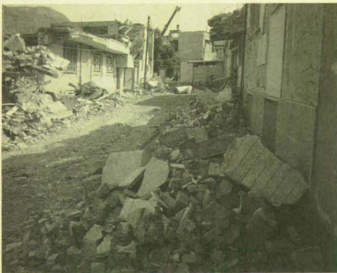
Die Hauptstraße von Rudbar ist ein einziges Trümmerfeld.
