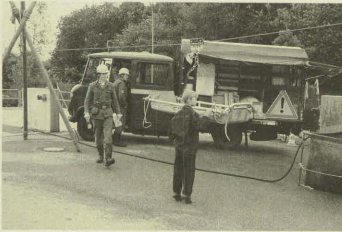
Das THW hatte unter anderem eine Seilbahn aufgebaut.
