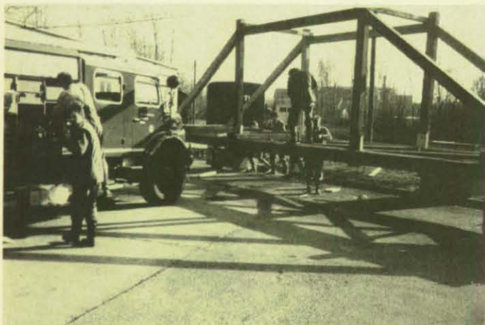
Bereits beim Bau auf dem THW-Gelände wird die Konstruktion der Brücke deutlich. (Foto: Krell)
