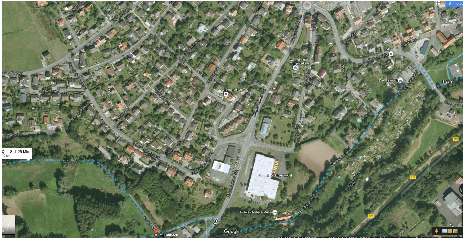
Bild 2) aus den Efzewiesen, Richtung Hohlebach Mühle, Überquerung Ziegenhainer Strasse, in den Kullbach
