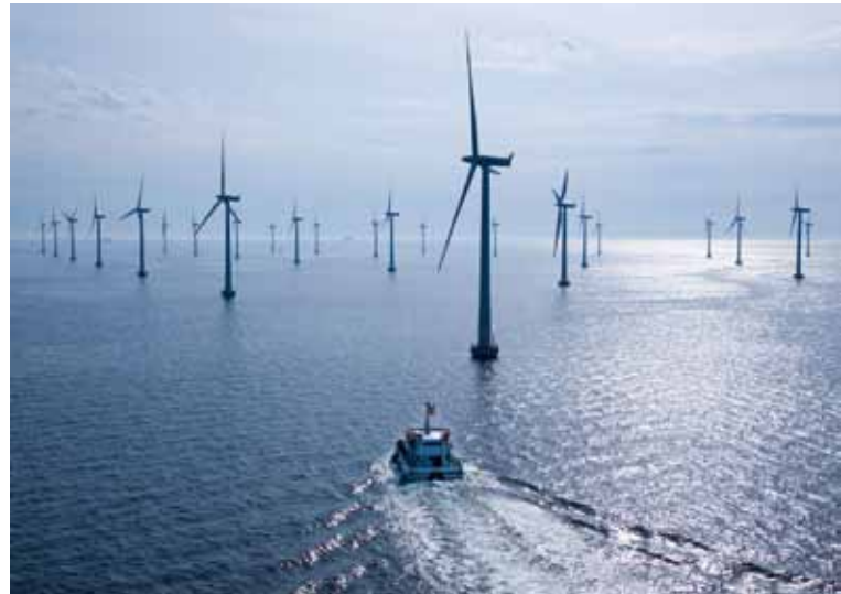
Schwedischer Offshore-Windpark Lillgrund
