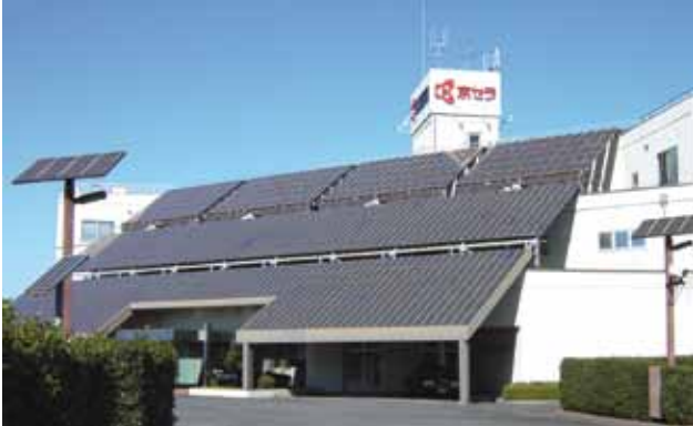
PV-Dach auf Kyocera-Firmensitz
