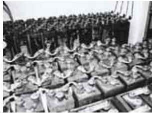
Nickel/Eisen-Batterien (z.T. 80 Jahre alt)
