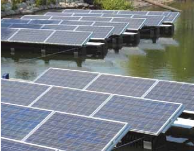
Schwimmende PV-Anlage (Far Niente)
