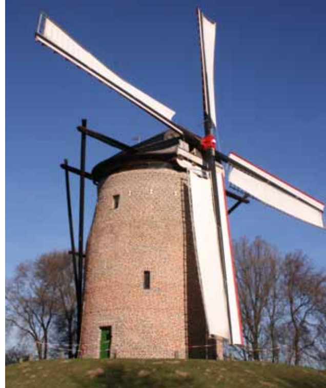
Turmwindmühlen Geismühle, Krefeld
