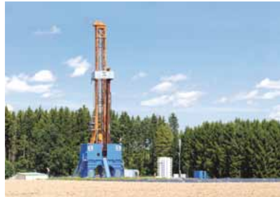
Bohrturm für Geothermie bei Hannover
