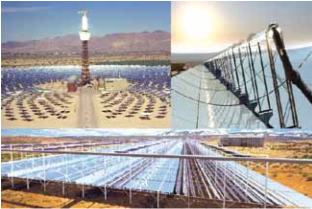
Solartower und Solarrinnenkollektoren
