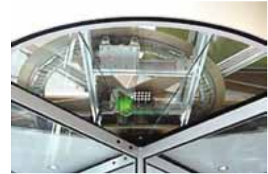
Strom-Drehtür - Detail des oben angebrachten Generators
