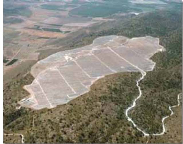
Großer Teil Planta Solar Fuente Alamo Hanglage
