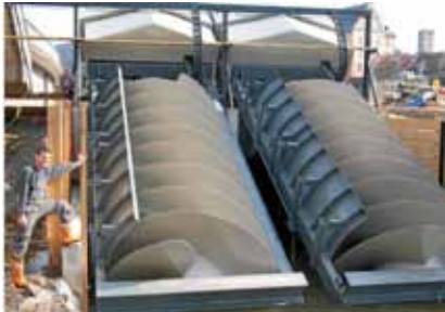
Bau des Wasserkraftwerk am Blümer Wehr in Hann. Münden im März 2011
