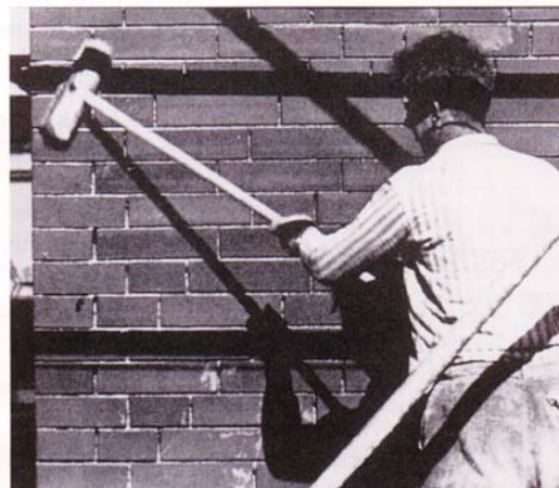
Abb. 4: 2. Angriffsfläche: Beim Absäuern wird der Mauermörtel in den offenen Fugen durch die Säure angegriffen.
