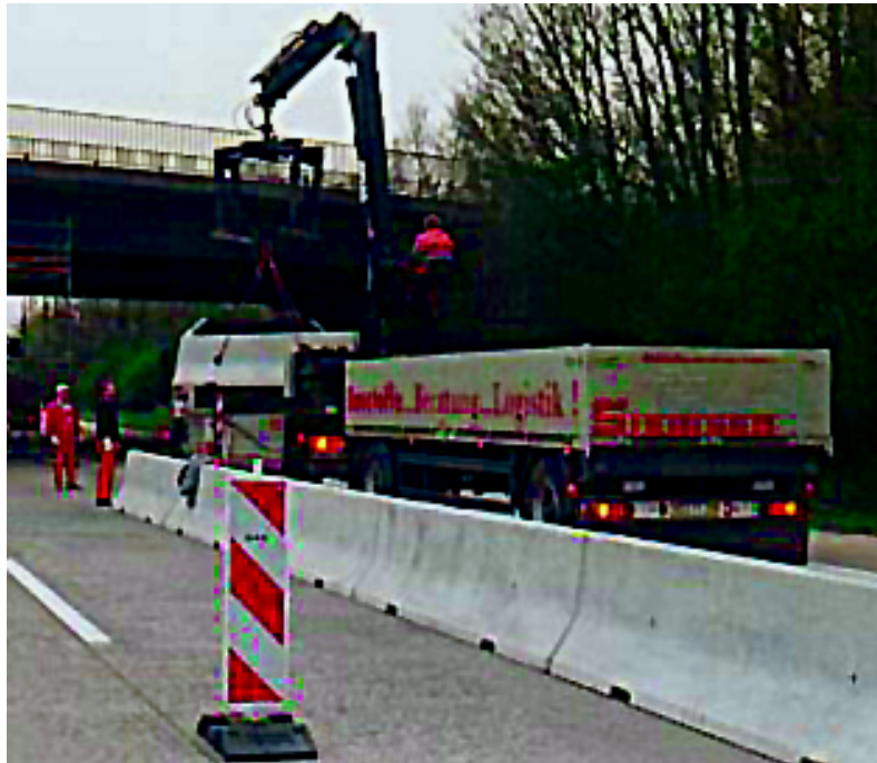
Bild 5: Betonschutzwandfertigteile mit der Aufhaltstufe T3 der Wirkungsbe- reichklasse W3
