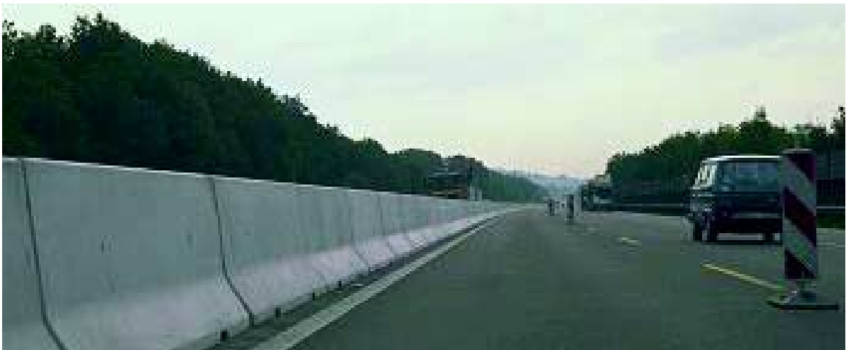
Bild 3: Betonschutzwandfertigteile mit Radabweiser im Mittelstreifen
