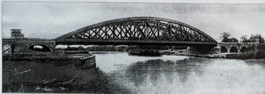
GB 8, BB 28, Nr. 35: Appleford-Eisenbahnbrücke bei Oxford (Oxfordshire). Eiserne Bogenbrücke der Great Western Railw. zwischen Didcot und Oxford über die Themse. Aufgehobener Horizontalschub, 3 vollwandige Parabelträger, gleichbleibende Bogenstärke, waagerechte Auflager, beiderseits Sparbögen in gemauerten Widerlagern; Zugsbahn zugleich Fahrbahn (unterliegend).
