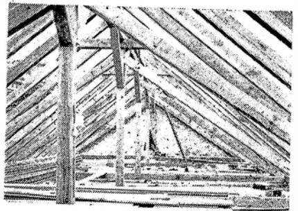
Dachkonstruktion: einfaches Sprengwerk.
