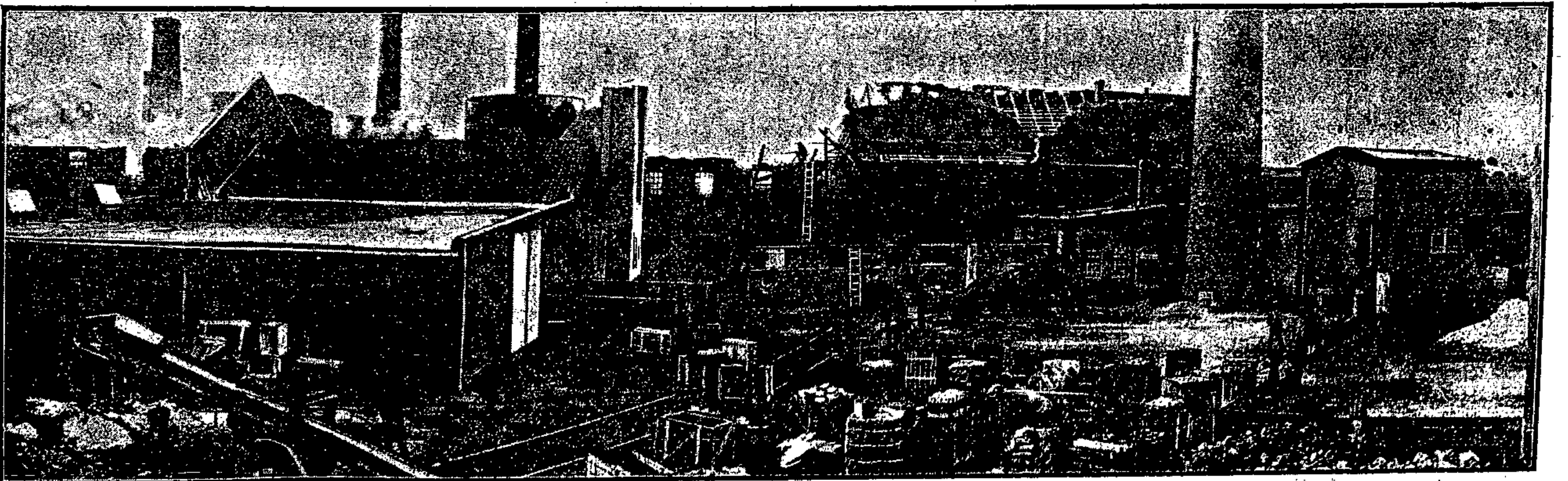
Die durch den Brand zerstörten Gebäude der Porzellanfabrik Sagonia.
