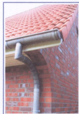
Giebelohren mit Fallrohr als Schwanenhals.
