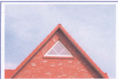
Dreiecksfenster im Giebelbereich.
