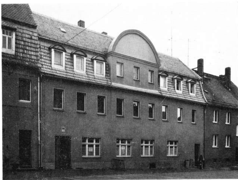
Das Stadthaus, Sitz des Rates der Stadt und der Zweigstelle der Kreissparkasse Grimma
