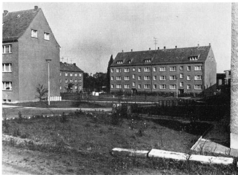
Seit 1975 errichtete Neubauten in der Straße der DSF
