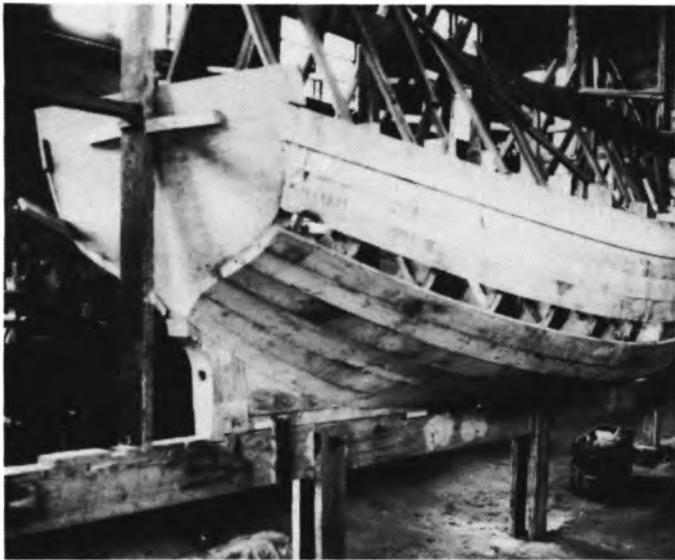
In der Beplankung fehlt nur noch der "Stopper", welcher leicht keilig gearbeitet ist und mit großer Wucht als letzte Planke in die Lücke getrieben wird. Die breite und stärkere Oberplanke ist das Bergholz.
