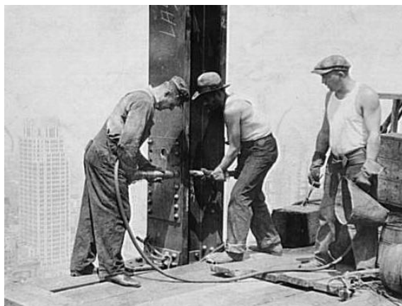
Abbildung 7: Nietverbindung an Stahlträgern im Hochhausbau (links), Schnappverbindung an einem PC-Gehäuse (rechts)
