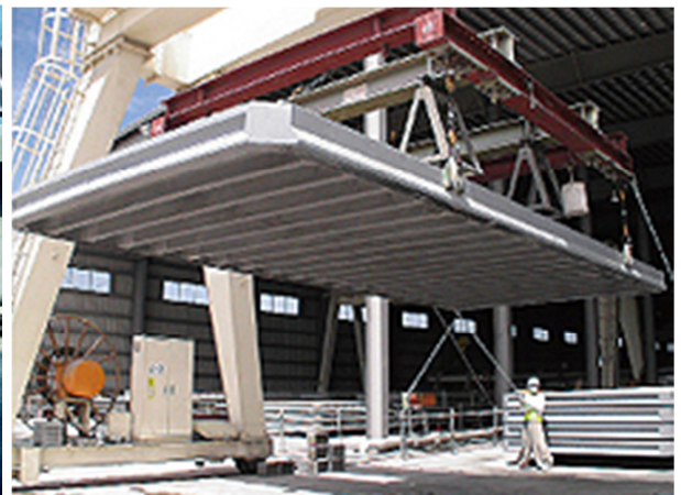
b) vorgespannte Rippenplatte, Haneda
