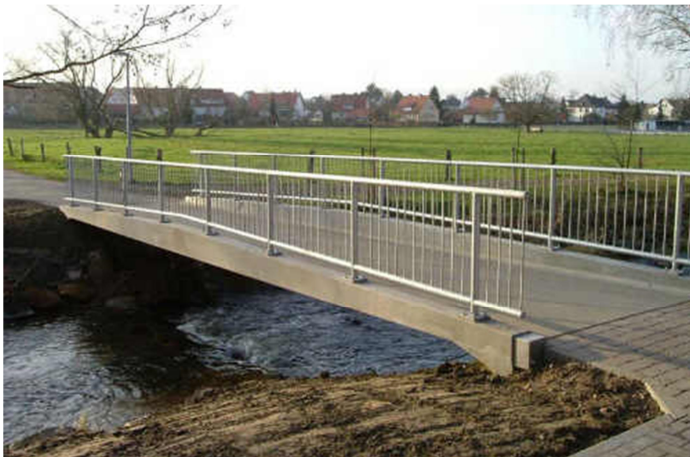
a) Fußgängerbrücke bei Niestetal
