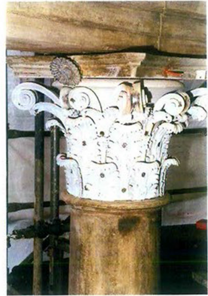
Abb. 6: Die Bleiteile der Akanthusblätter wurden mit Edelstahlschrauben angeschraubt und zum Teil zusammengelötet.
