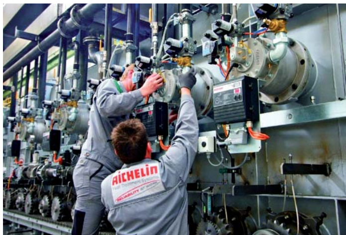
Bild 1: Inspektion einer Rollenherdfenanlage
