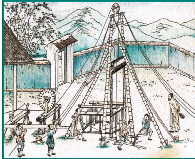
1 Chinesische Darstellung einer Bohreinrichtung
