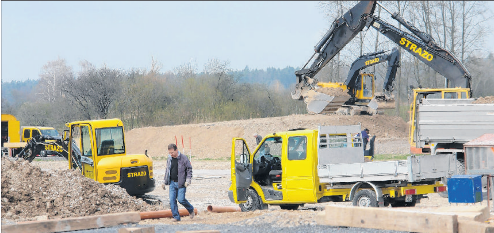
Die Bauarbeiten für die KMU-Boxen in der Ustermer Loren haben begonnen. Ende 2008 sind die ersten Einheiten fertig. (sti)
