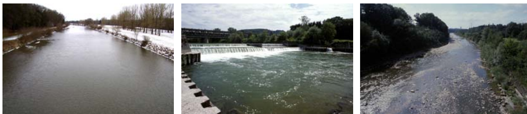
Abb. 60: a) Defizit an Strukturen im Fluss; b) unterbrochenes Längskontinuum; c) Restwasserabfluss unterhalb Weinfelden
