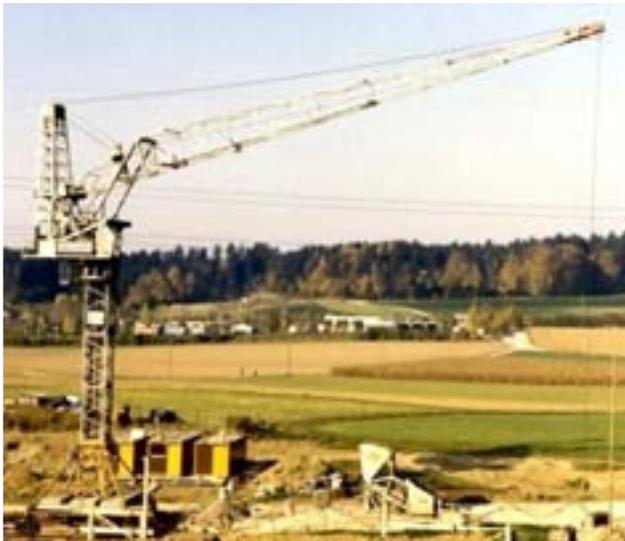
Liebherr entwickelte Ende der 50er Jahre ein Kransystem namens HB - ein Obendreher-Kletterkran mit Verstell- oder Wippausleger. Die Auslegerverstellung erfolgte bei diesen Kranen mittels Hydraulik. Eine weitere Besonderheit war der horizontale Lastweg des Kranhakens. Somit konnte ein Vorteil der Katzausleger-Kransysteme kompensiert werden.
