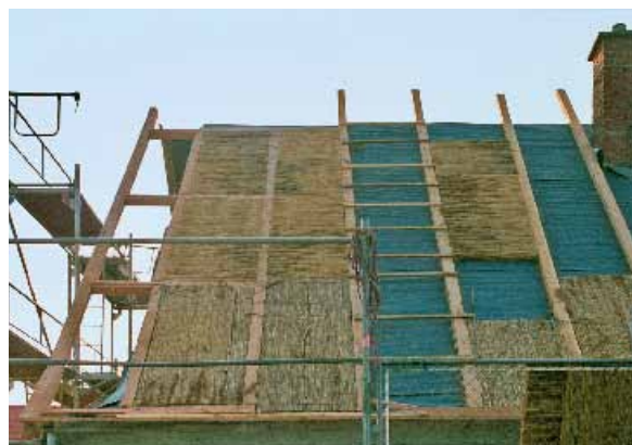
Statisch tragende Kanthölzer sind mit bis zu 40 cm langen Schrauben mit den alten Sparren verklammert. Zwischen sie wurden 8 cm starke Schilfplatten eingepasst
