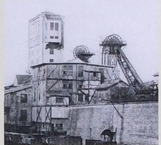
Hammerkopf-Förderturm der Grube Camphausen (links), um 1920.
