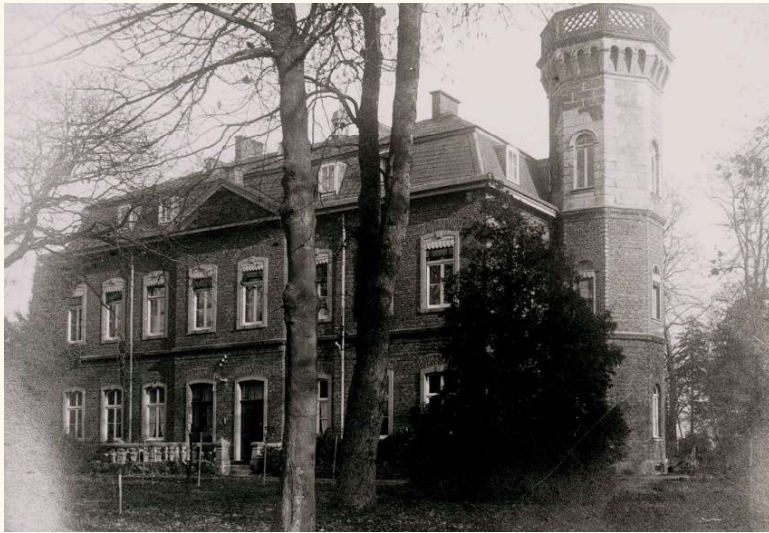
Die Rückseite des Schulgebäudes, unter dem Fenster ganz links lag unsere geheime Kohlenentnahmestelle © Walter Meyer
