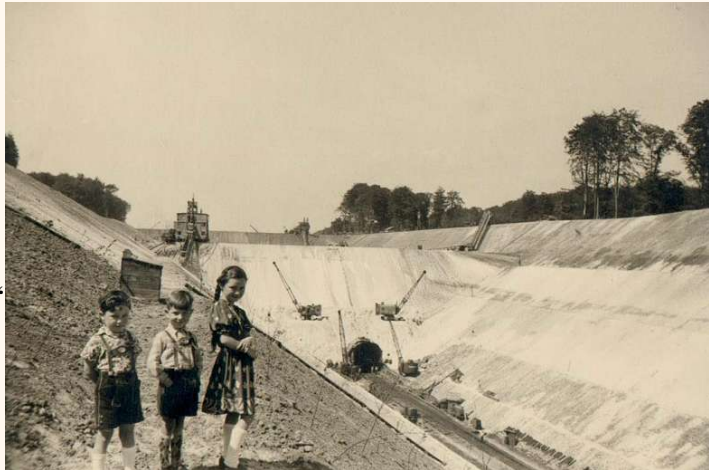
Besuch auf der Baustelle © Walter Meyer
