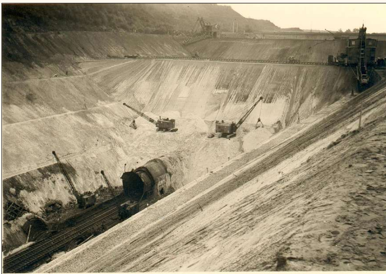
Blick auf die Baustelle © Walter Meyer
