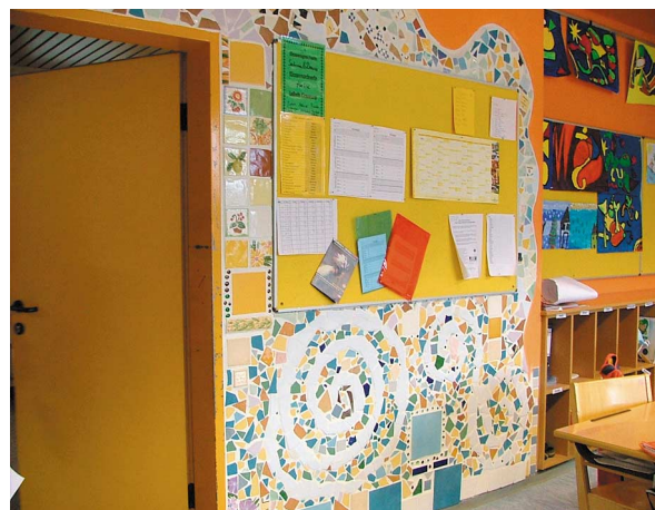
Abb. 8: Fertig gestelltes Fliesenmosaik. Die Konturen wurden vorher festgelegt, es wurde von außen nach innen gearbeitet. Mosaik bieten sich vor allem auch besonders an solchen Stellen an, die durch viele Kontakte stark strapaziert werden (Waschbecken, Ein- und Ausgänge, Pinwände).
