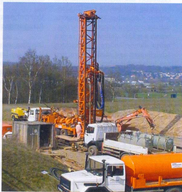
Herstellung einer 500 m tiefen Beobachtungsbohrung in Hessen
