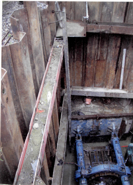
Abb. 4: Startgrube für Rohrvortrieb, Zugang über Steigleiter hier nur unter Verwendung von PSAGÄ möglich (Pressgrube)
