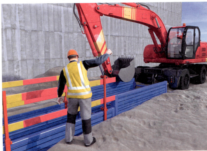
Abb. 13: Absturzsicherung am Verbau bei Baggararbeiten am Graben
