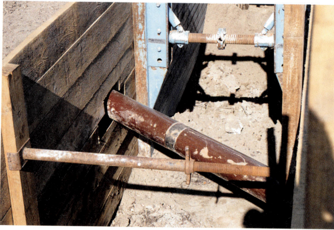
Abb. 9: Kreuzende Leitung, mit waagrechttem Verbau eingefasst
