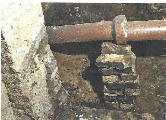
Ursache für das Feuchtigkeitsaufkommen im Keller war ein gebrochenes Abflussrohr
