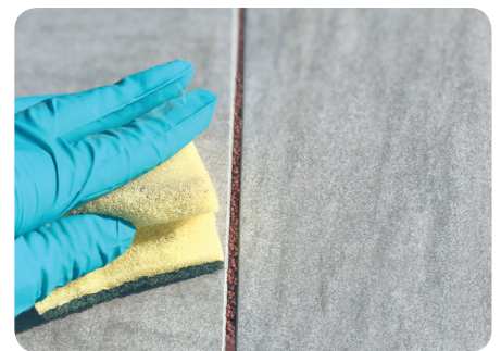
Rückstände mit feuchtem Schwamm aufnehmen
