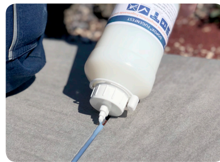
Bindemittel ausschließlich auf die Fuge aufbringen
