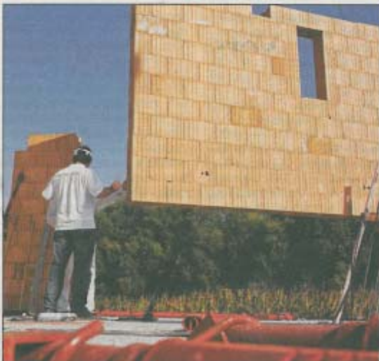
Fertigwand statt vor Ort mauern
