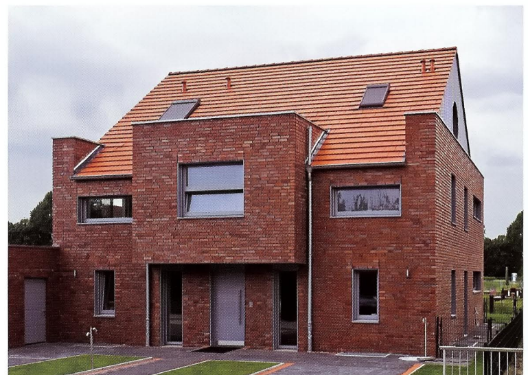
Ansicht von Norden
