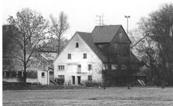
Beim Einbau von Mühlenmaschinen reichte mancherorts ein Dachausbau aus: die Kernmühle an der Kanzach zwischen Unlingen und Daugendorf (März 1989).
