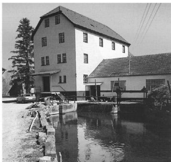
In Achstetten ist die Mühle noch im Dorf geblieben: Getreide- und Sägemühle Hermann an der Rot (Juli 1989).
